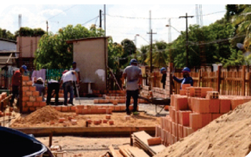
Construção em andamento – aula prática
